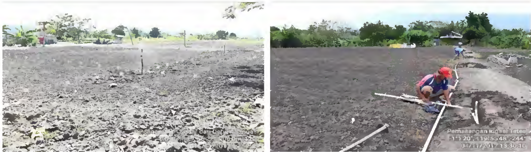
Gambar 11. Perakitan komponen dan instalasi jaringan irigasi di lapangan
