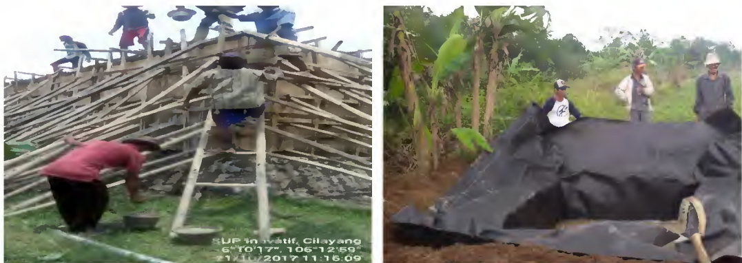
Gambar 16. Pembangunan bak besar (kiri) dan pemasangan bak mini dengan geomembrane (kanan)
