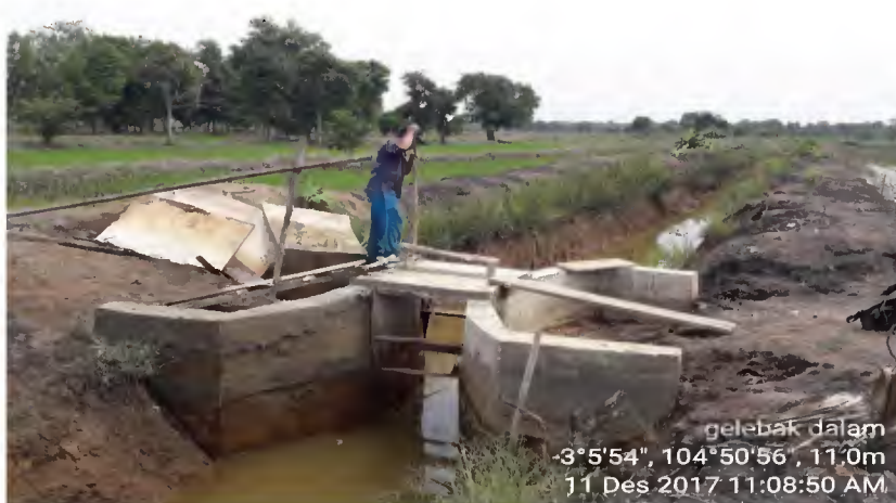
Gambar 13. Saluran dan Pintu Air
