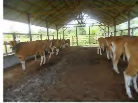
Perbaikan kandang kelompok di kelp. Sumber makmur, ds. Natai raya, kec. Arut, kab. Kobar
